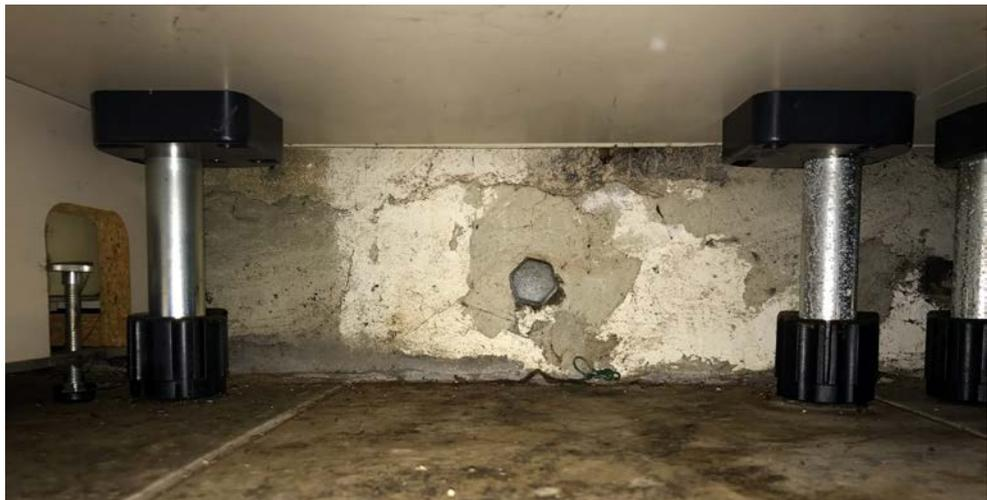
Abbildung 3: Verdeckter Schimmelschaden, Innenbereich Leichtbauwand (Quelle: P. Tappler, IBO Innenraumanalytik OG)
