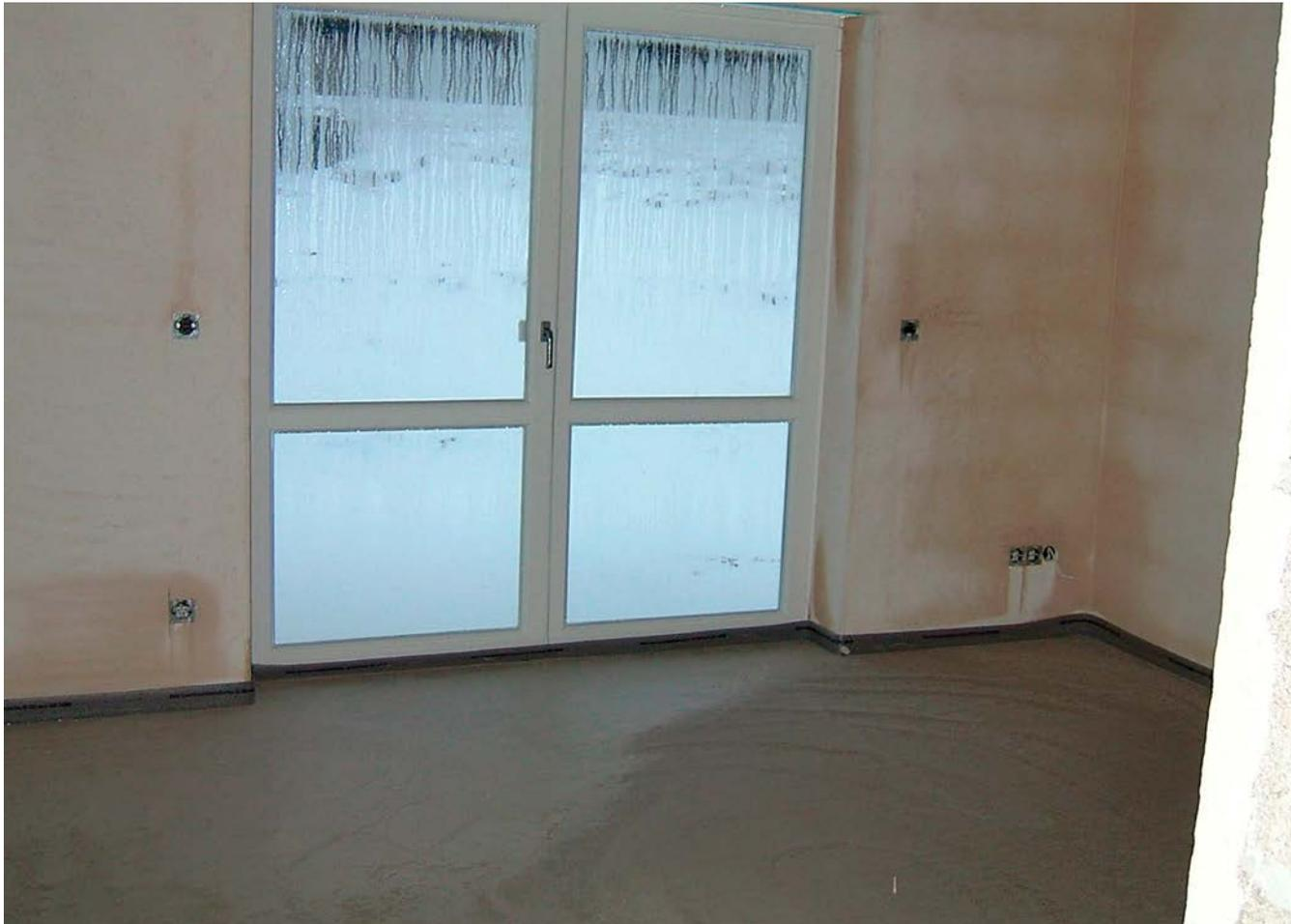
Abbildung 20: Schimmelschaden durch Neubaufeuchte (Quelle: S. Betz, Sachverständigenbüro für Gebäude- und Innenraumanalytik, Hellertshausen)
